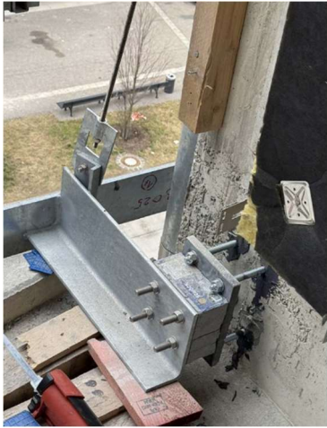
Isokorb T S im Einsatz an einer der Ecken des Wohnturms. Bild: Dipl.-Ing. Hölscher GmbH & Co. KG/ H. Hölscher
