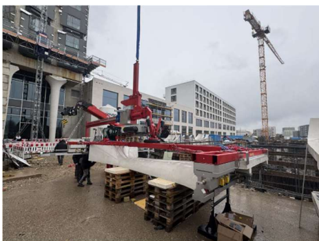
Die einzelnen Steine werden mit dem eigens dafür hergestellten Saugroboter angehoben, ... Bild: Dipl.-Ing. Hölscher GmbH & Co. KG/ H. Hölscher
