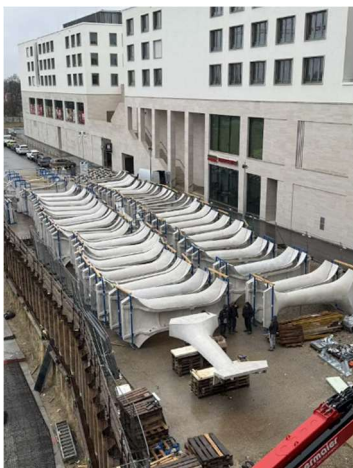
Anlieferung auf Vorrat: Die Fassadenelemente werden in größeren Einheiten auf die Baustelle gebracht, um dann Stück für Stück eingehoben zu werden. Bild: Dipl.-Ing. Hölscher GmbH & Co. KG/ H. Hölscher
