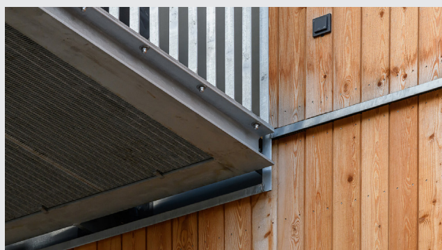
Balcon en porte-à-faux fixé sur structure bois avec Isokorb® T S, assurant une liaison acier-bois performante.
