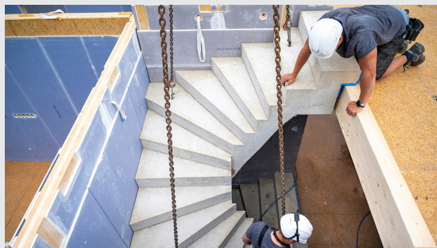
Schöck Tronsole® : liaison sûre et performance acoustique pour escaliers préfabriqués en béton armé, y compris dans les constructions en bois et hybrides.
