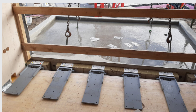
Dalle de balcon béton, préassemblée de rupteurs Isokorb® XT SK et de consoles d'acier fixée sur plancher bois.
