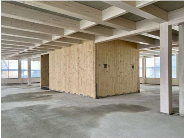
*Das Fluchttreppenhaus im Rohbaustadium, als die Trockenbau-Wände noch nicht erstellt waren. In diesem Bauabschnitt erfolgte die erste Trittschallmessung.
