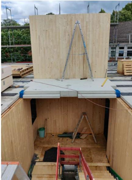
*Um die Anforderungen von 53 dB an den Trittschallschutz der Treppen einzuhalten, wurden zur Entkopplung des Flucht-Treppenhauses verschiedene Typen von Schöck Tronsole eingesetzt. Hier im Bild: Tronsole Typ Z zur akustischen Entkopplung des Hauptpodestes.*
