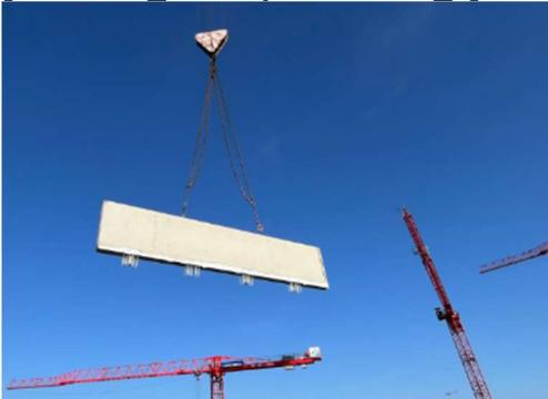
Ein Brüstungselement für die Attika wird per Kran eingehoben.
