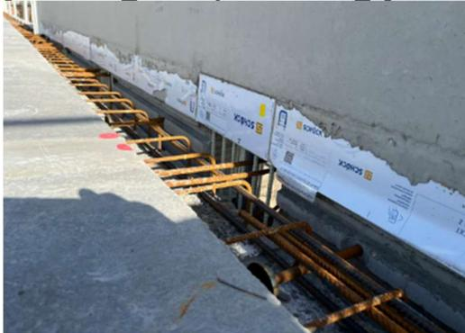
Das Brüstungselement wird in die Betoniergasse in die vorhandene Bewehrung der Vollfertigteildecke eingefügt.
