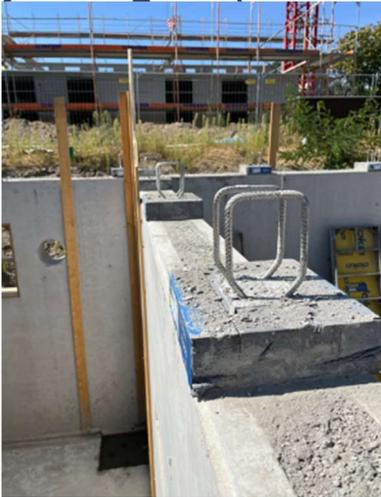
*Schöck Sconnex Typ W wird beim Verfüllen der Wände mit Ortbeton mit einbetoniert.
