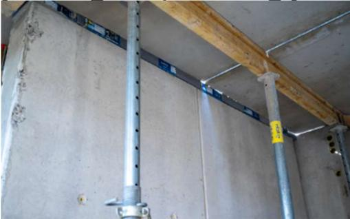
Zwischen den tragenden Wärmedämmelementen sorgt das nicht tragende Dämmteil Part Z für eine durchgehende Wärmedämmebene.
