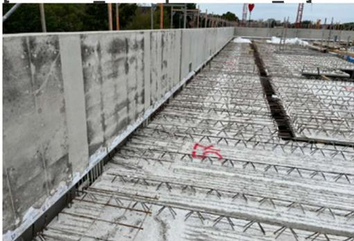
Beispiel für die Platzierung der Brüstungselemente auf Elementdecken, bevor der Beton aufgebracht wird.
