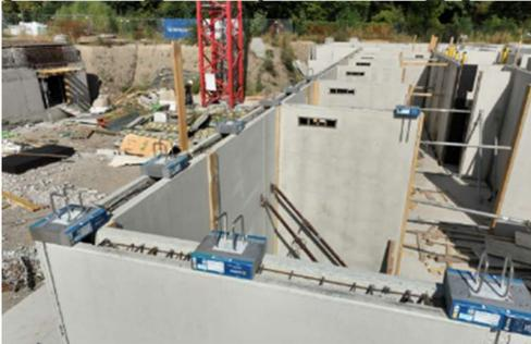
*Schöck Sconnex Typ W wird auf die Wandschalen der Elementwände im Untergeschoss aufgesetzt.
