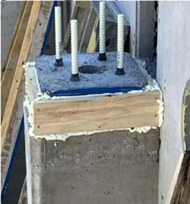
*Schöck Sconnex Typ P kommt an Stützenköpfen zur punktuellen Lastabtragung zum Einsatz.
