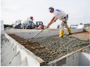
Concreting the outer shell panel. Photo: Schöck Bauteile GmbH
