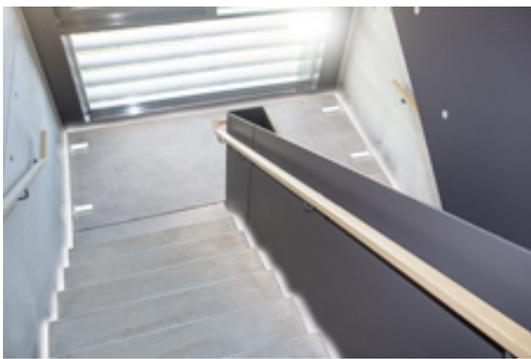
*Die Tronsole Typ P ermöglicht die Umsetzung besonderer Projektanforderungen wie umlaufende Luftfugen oder effektvolle Lichtbänder. Foto: Schöck Bauteile GmbH*
