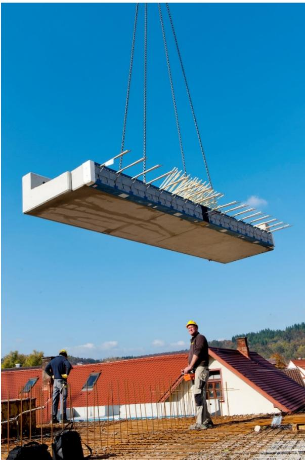
*Die neun Meter langen Balkone wurden in zwei Teile geteilt, sodass die Bauteile problemlos auf der temporären Unterkonstruktion positioniert werden konnten.
