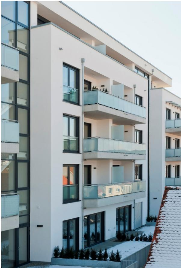
*Da fast jede Wohnung mit einem Balkon geplant ist, musste besonders bei den Balkonanschlüssen auf Wärmebrücken geachtet werden. Foto: Schöck Bauteile GmbH, Abdruck honorarfrei.*
