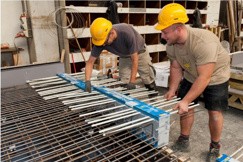
*Aus Gewichts- und Platzgründen wurden die Balkone als sechs Zentimeter starkes Halbfertigteil im Fertigteilwerk realisiert. Foto: Schöck Bauteile GmbH, Abdruck honorarfrei.*
