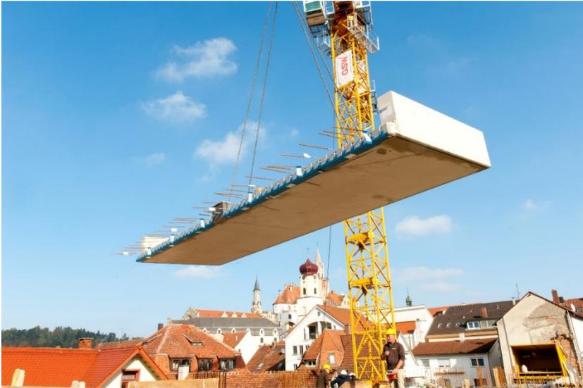
*Die 3,6 Tonnen schweren Bauteile wurden mit dem Kran in Position gebracht.
