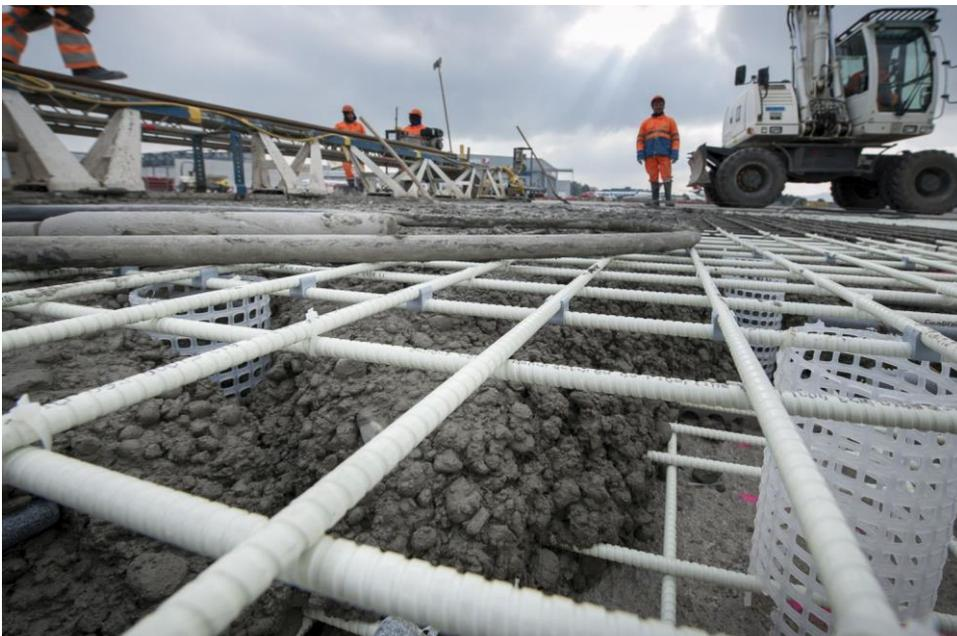
*Combar von Schöck ist eine glasfaserverstärkte Kunststoffbewehrung, die weder elektrische noch magnetische Ströme leitet. Foto: Thomas Entzeroth*
