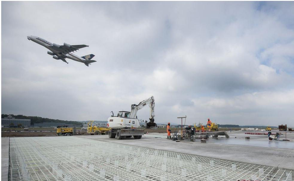
*Mit einer Spezialbewehrung der Betonplatten aus glasfaserverstärktem Kunststoff wird die störungsfreie Kommunikation des Sicherheitssystems gewährleistet. Foto: Thomas Entzeroth*
