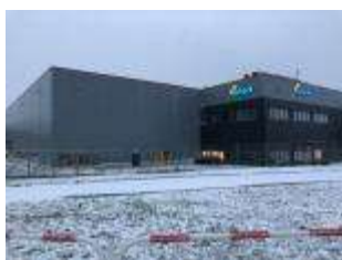
Nowa fabryka w Tychach. Fot. Schöck
