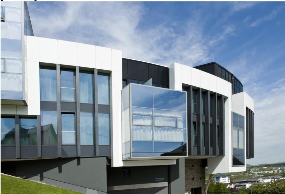
*Die Fassade aus einer vorgesetzten Stahlkonstruktion konnte dank des Isokorb Typ KS zuverlässig mit geringem Zeitaufwand montiert werden. Foto: Schöck Bauteile GmbH, Abdruck honorarfrei.*
