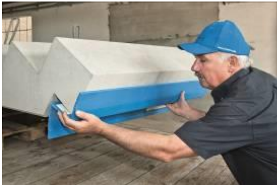
Montaż elementu Schöck Tronsole typu F Fot. Schöck
