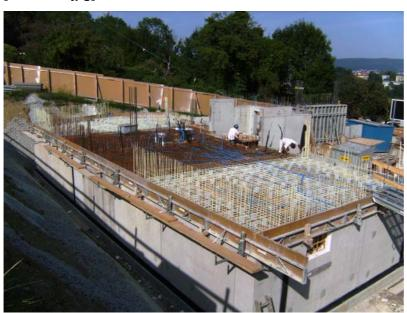
Bewehrung mit besonderen Eigenschaften: Die Glasfaserbewehrung Schöck ComBAR ist nicht magnetisierbar, leitet keine elektrischen Ströme, ist korrosionsresistent und wesentlich leichter als Betonstahl.
