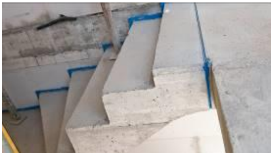
Proste tworzenie połączeń na klatce schodowej za pomocą Schöck Tronsole typu T Fot. Schöck
