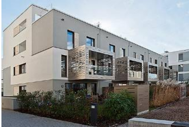
Mostki cieplne powstające przy przerwaniu ciągłości elewacji przez stalowe konstrukcje balkonowe to często lekceważony problem.
