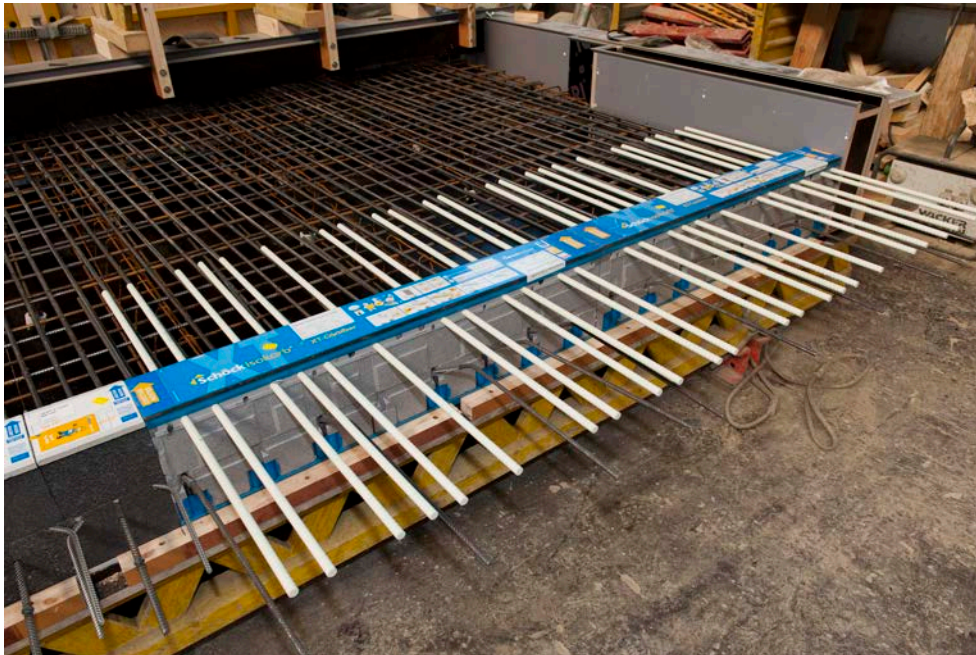
[Eingesetzter Isokorb.jpg]
