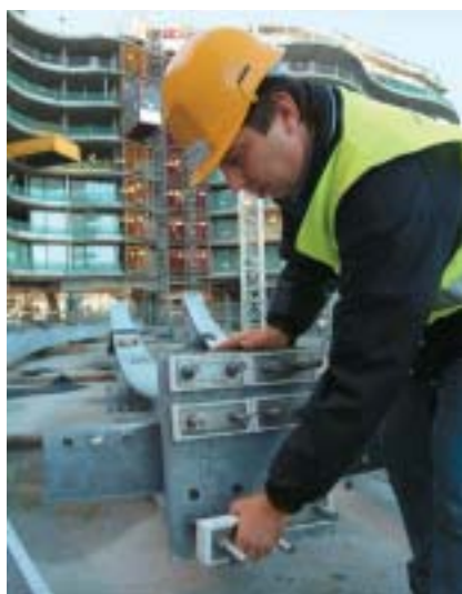
Montage des Schöck Isokorb® KST an Stahlträger
