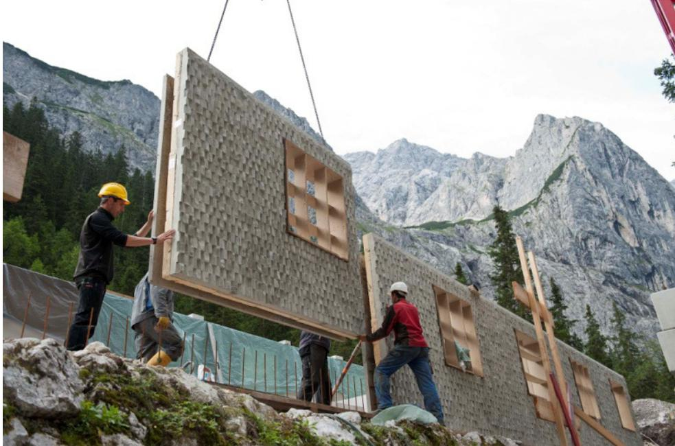
*Für eine schnelle und einfache Errichtung des Sockelgeschosses wurden beim Fertigteilwerk Siegl vorgefertigte Elementwände mit Schöck Thermoanker bestellt.*
