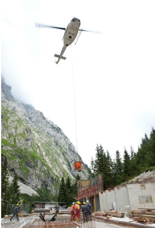
*Das Höllental liegt in 1392 Metern Höhe und hat keine Straßenanbindung. Alle Bauelemente müssen per Hubschrauber einzeln hochgeflogen werden.*
