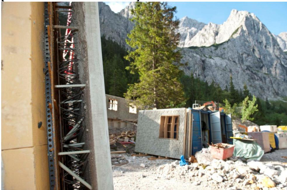
*Die kerngedämmten Elementwände sind mit dem Schöck Thermoanker versehen. Aus glasfaserverstärktem Kunststoff gefertigt, sorgt er für minimierte Wärmebrücken und agiert zugleich als Verbindungselement und Abstandhalter.*
