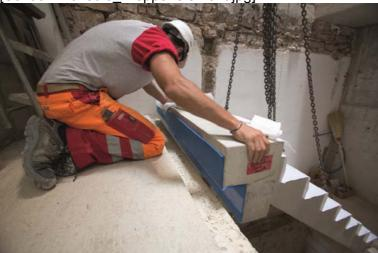
Das vorfabrizierte Treppenelement wird ohne zusätzliches Betonieren oder Kleben an der entsprechenden Stelle aufgelegt. Die Tronsole von Schöck dient nun als Schallbarriere zwischen den zwei Bauteilen.
