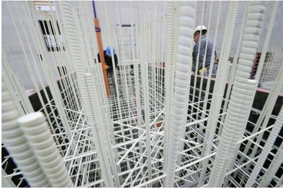
*Bauaufsichtliche Zulassung des DIBt für den geraden Glasfaserbewehrungsstab Schöck ComBAR mit den Nenndurchmessern 8, 12, 16, 20 und 25 Millimetern. Damit ist Schöck derzeit der einzige Hersteller auf dem Deutschen Markt mit einer bauaufsichtlichen Zulassung für Glasfaserbewehrungsstäbe.*
