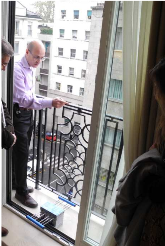
Foto 4: l'ingegnere responsabile del progetto "Palazzo Parigi" mostra con l'ausilio di un campione dove è stato posato esattamente Isokorb®
