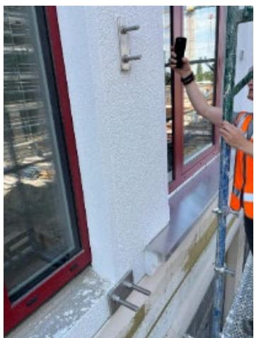
Die Stirnplatten von insgesamt vier Modulen von Schöck Isokorb T S pro Balkon liegen samt überstehender Gewindestangen vor der Fassade. Die beiden oberen Module nehmen die Zug- die beiden unteren die Druckkräfte der Balkone auf.
