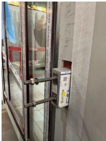
Ein fertiges Raummodul mit Decke, Wänden und Fensterelementen. Der obere Isokorb ist ebenfalls komplett vorinstalliert und kragt aus. Die langen Gewindestangen überbrücken die Distanz bis zum Balkon, die durch den Fassadenaufbau mit Wärmedämmung und Putz entsteht.
