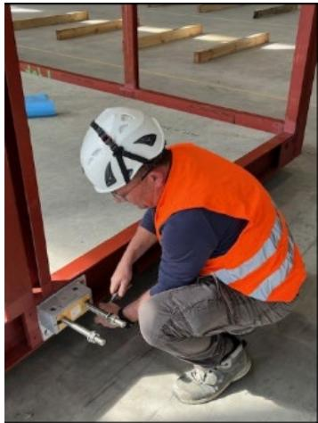
Testmontage im Werk: Schöck Isokorb T S-V, der die Druckkräfte aufnimmt, wird, um Transportschäden zu vermeiden, erst auf der Baustelle über die Ankerplatte an die Adapterplatte/Kontaktplatte des Stahlrahmens geschraubt.
