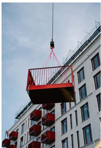
Bei den 759 frei auskragenden Balkonen handelt es sich um Stahlkonstruktionen, die nur noch an den Stahlrahmen der Module angeschraubt werden.
