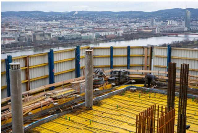
*Schöck Isokorb XT und die Bewehrung der Betonplatte greifen ineinander – für eine zuverlässige Tragfähigkeit.*
