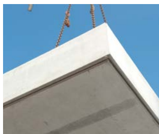
4. Verwijder de dichtingsstrip na het optillen van de plaat
