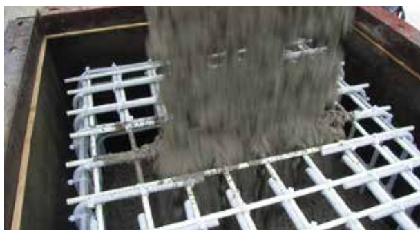
L'armature en fibres de verre Schöck Combar® est commandée et posée de la même façon que l'acier à béton conventionnel.
