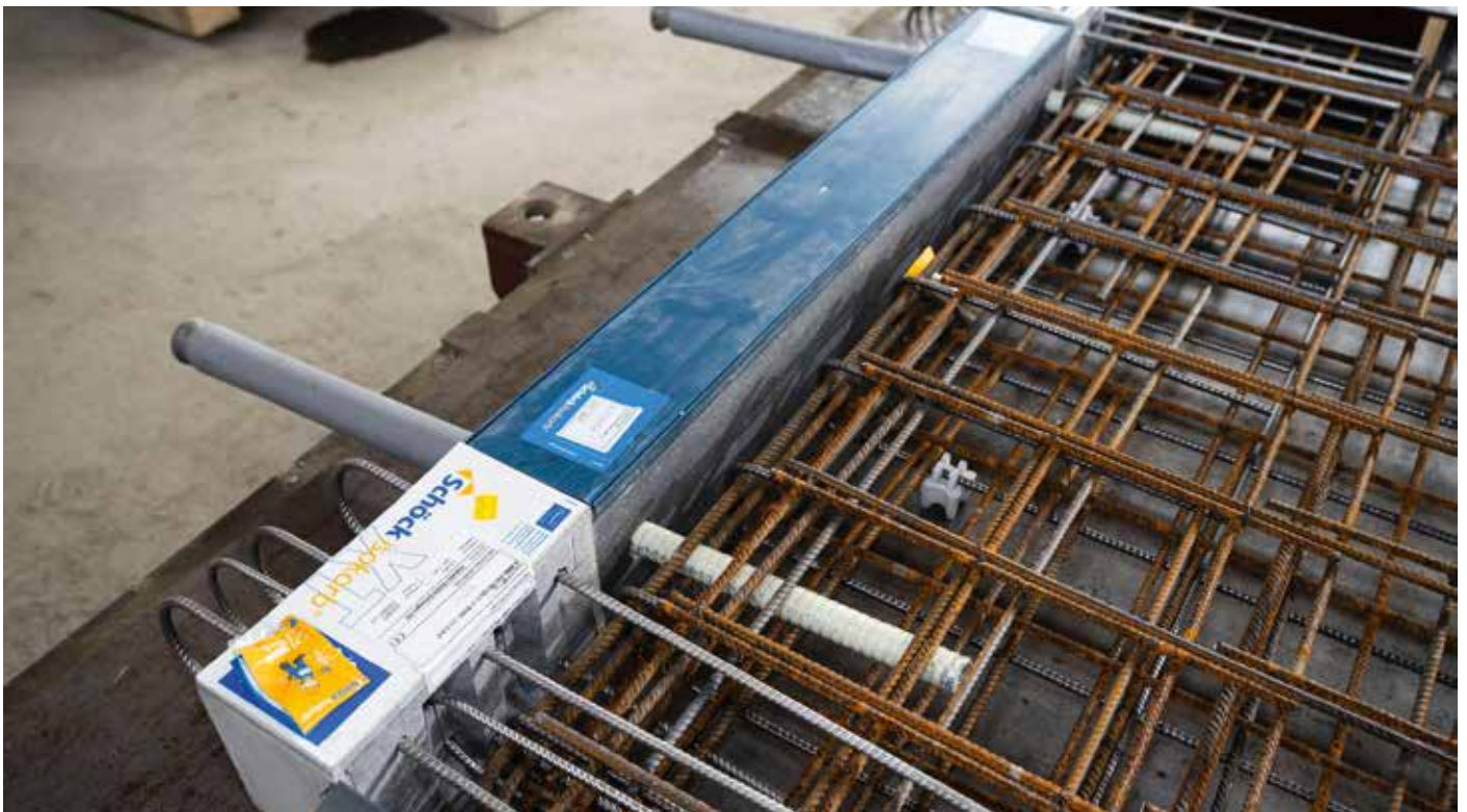
Einbau des Isokorb® Typ A mit Typ Z und Combar® FT-Montagstütze im Fertigteilverk, Typ Z um 90° gedreht
