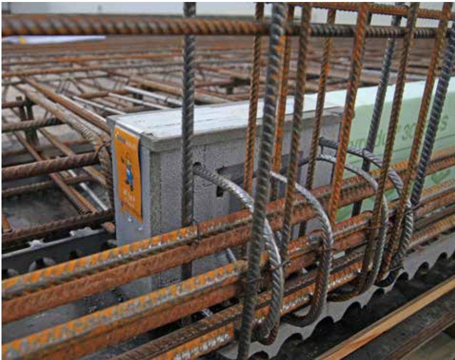
Abb. 4: Fixierung der Attika-Horizontalbewehrung
