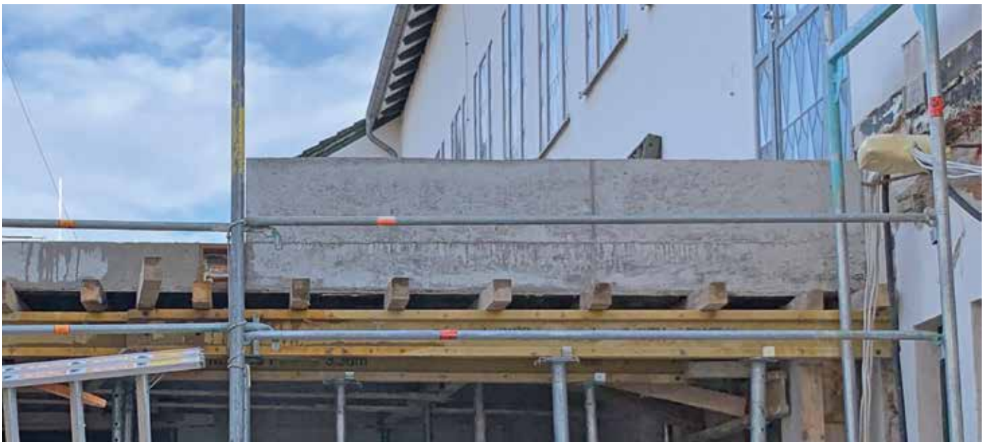
Abb. 6: Ausgeschalte Attika nach der Betonage
