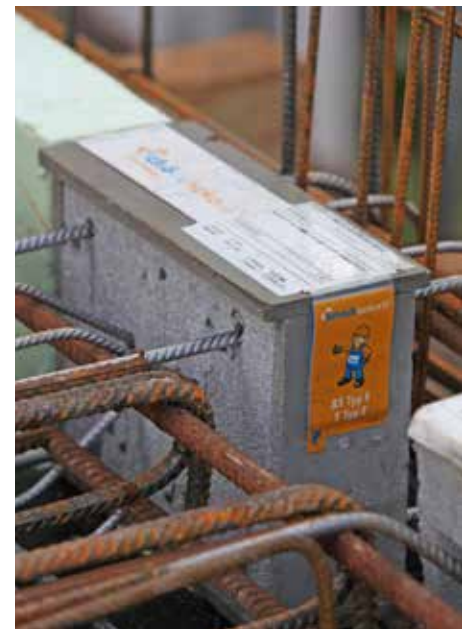
Abb. 3: Einbringen der Zwischendämmung
