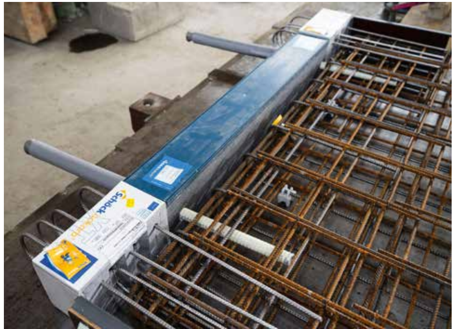
Abb. 5: Isokorb® Dämmzwischenstück und Montagestütze
