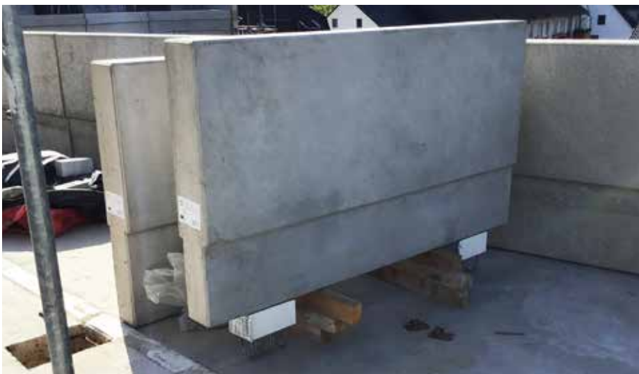
Fertigteil mit einem Versatz zum Verkleben der Abdichtung
