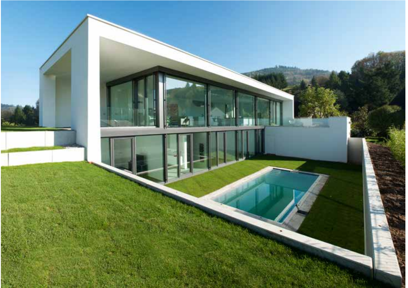
Einfamilienhaus im Passivhausstandard, Bühl
