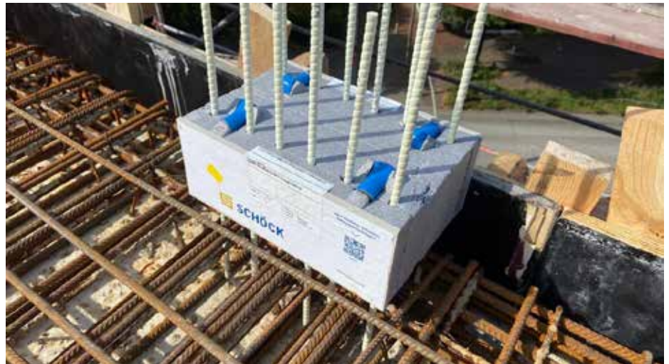
Abb. 1: Isokorb® in Bewehrung einstellen und fixieren
