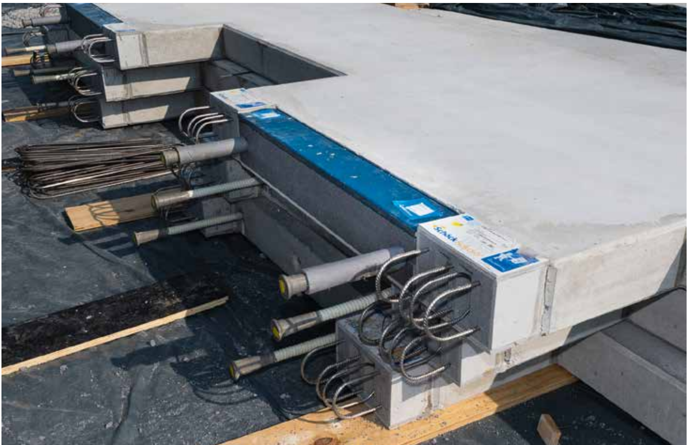
Abb. 2: Fertigteil mit Isokorb® Typ A, Typ Z und Combar® Fertigteil (FT) - Montagstütze
