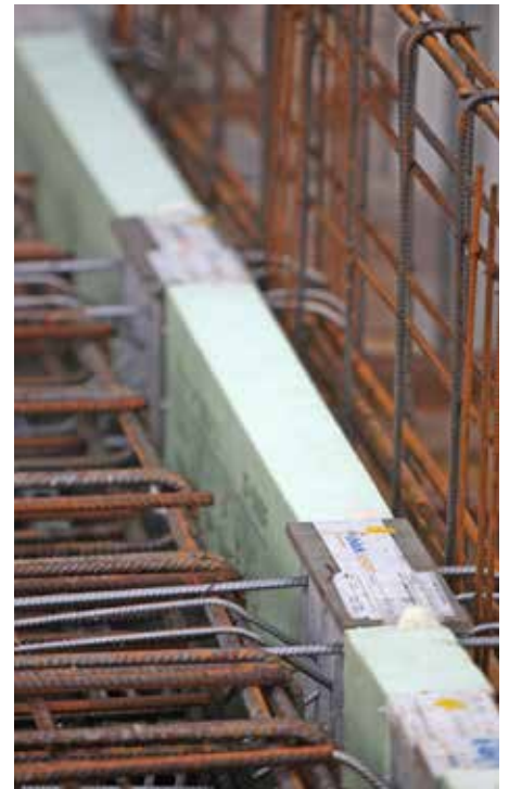
Abb. 5: Erstellen der Attika-Bewehrung
