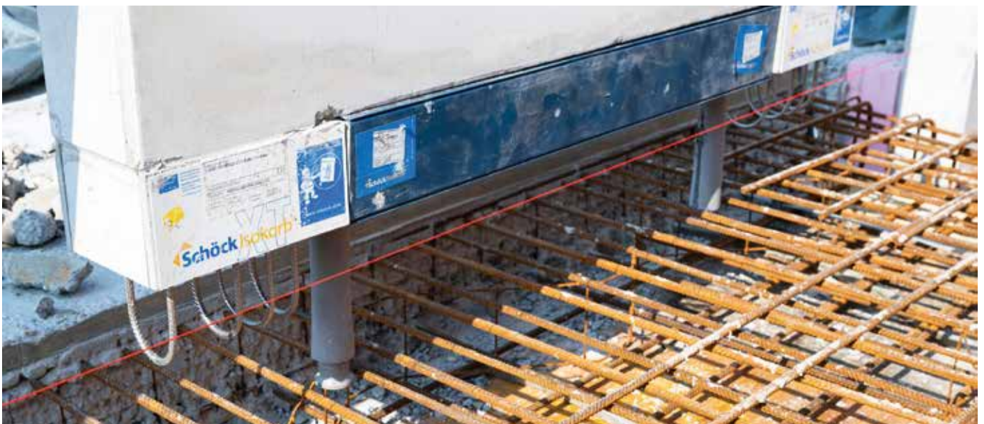
Einbau der Fertigteillattika auf der Baustelle
