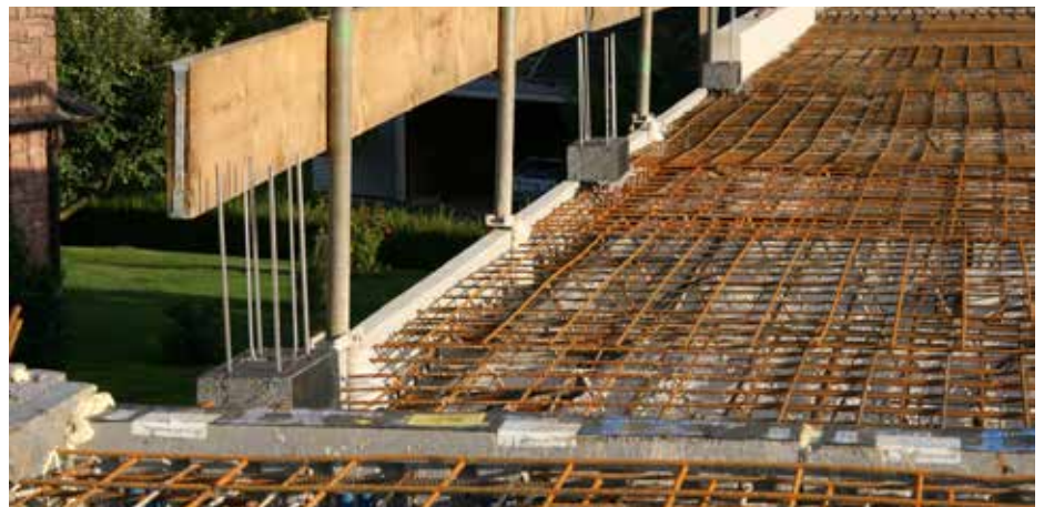
Isokorb® XT Typ A in Deckenbewehrung
