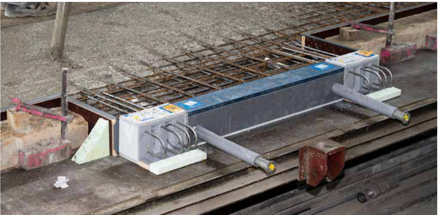
Abb. 6: Betonieren und verdichten
