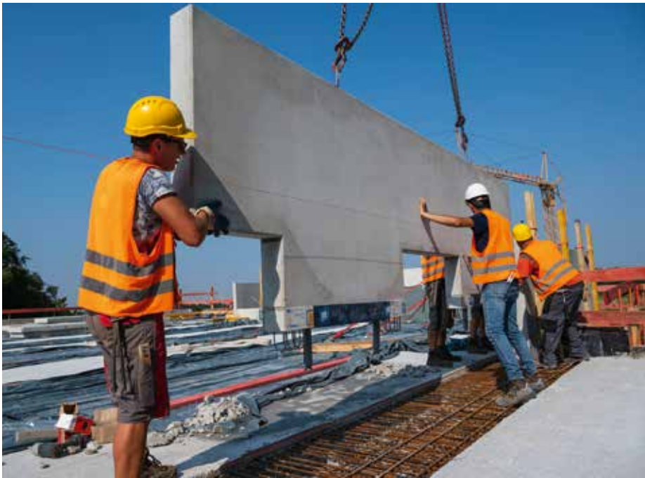
Abb. 3: Attika einsetzen
