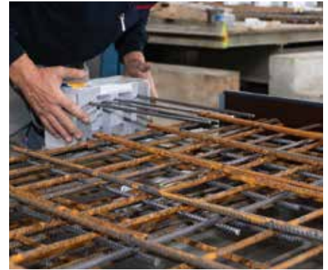
Abb. 2: Isokorb® CXT/XT Typ A einbauen
