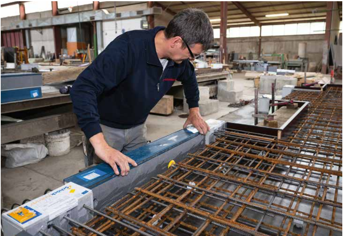
Abb. 3: Dämmzwischenstück Isokorb® Typ Z um 90° gedreht einsetzen
