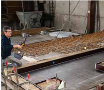
Abb. 1: Schalung für Fertigteil herstellen
