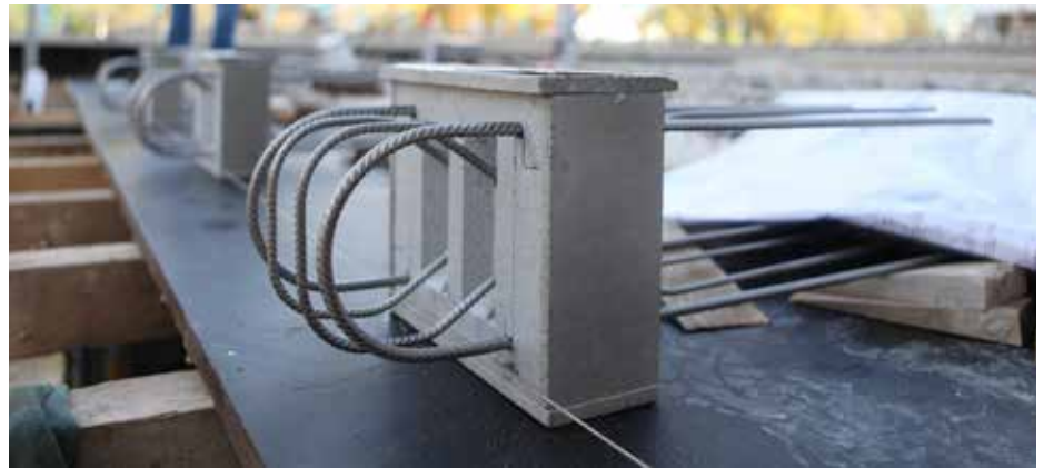
Abb. 1: Positionieren des Typ F am Deckenrand
