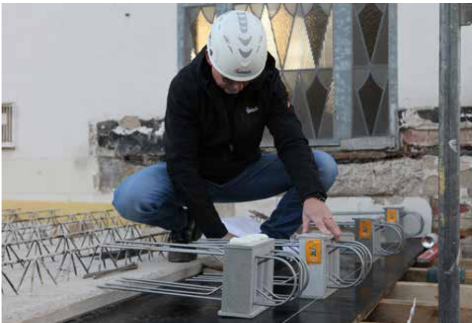
Abb. 2: Fixieren des Typ F mit Montageschaum
