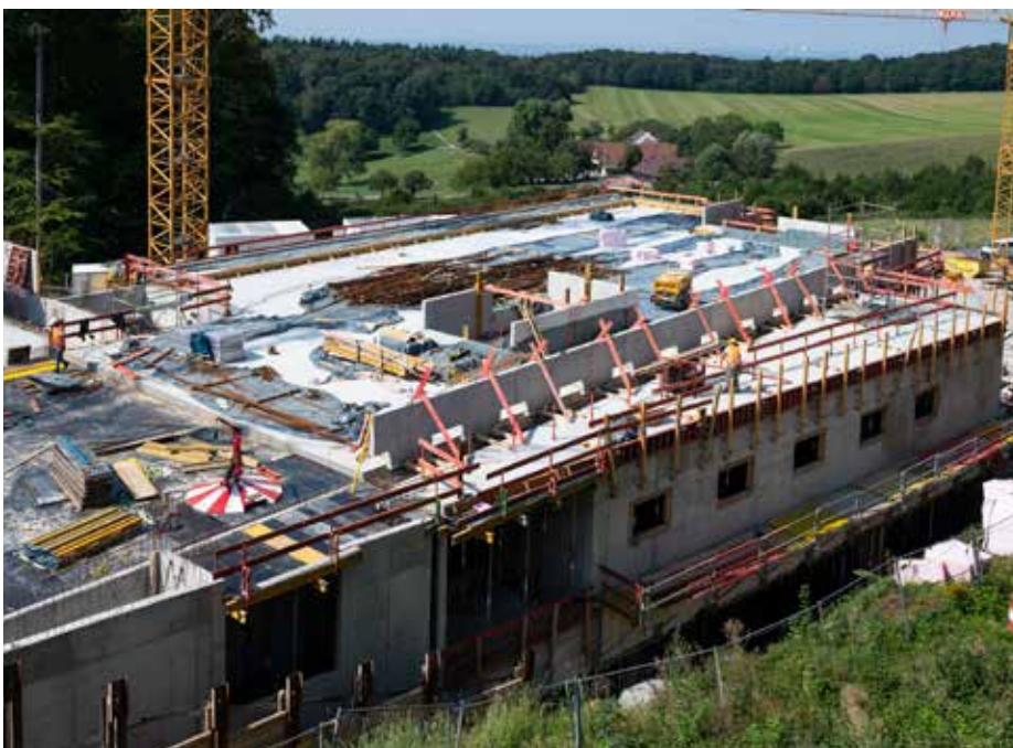
Abb. 5: Betonieren der Decke
