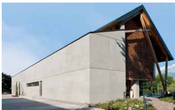
Spa des Saules, Illhaeusern © Schöck Bauteile GmbH
