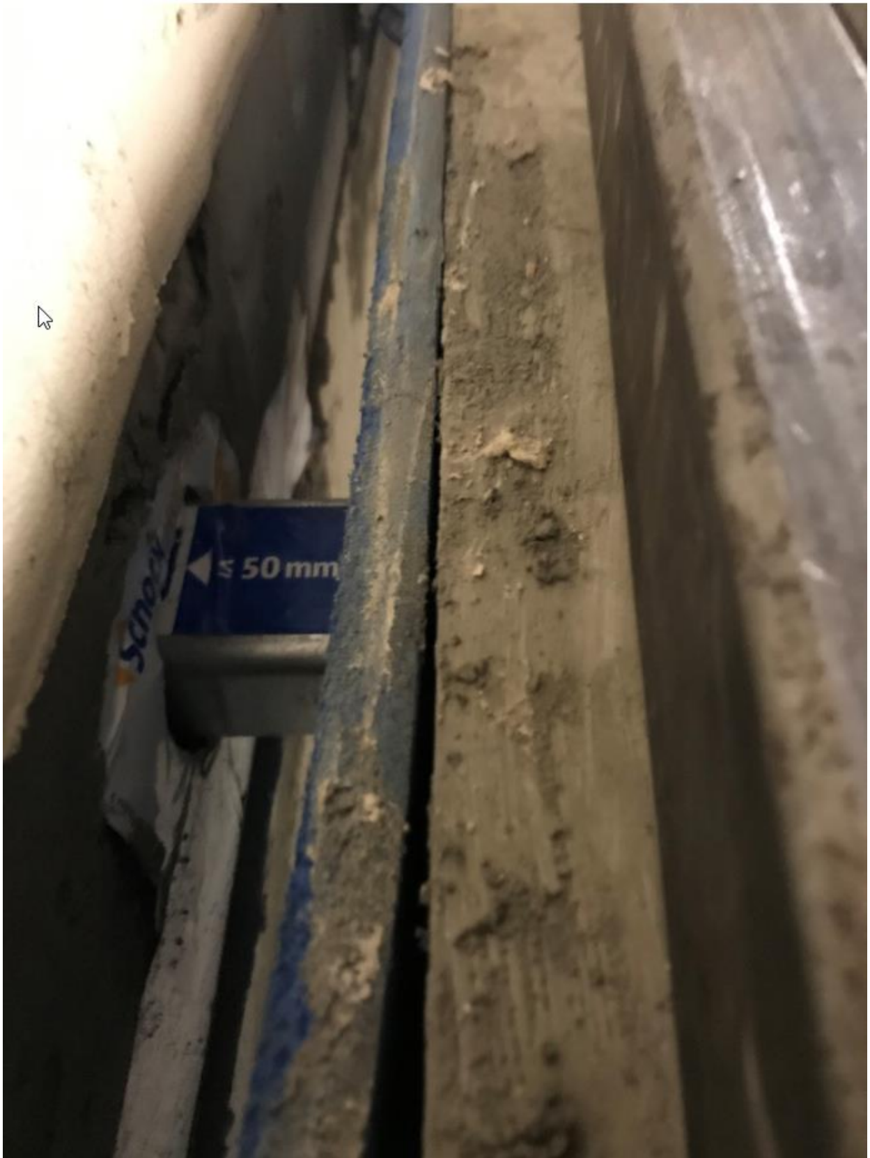
Abbildung 7: Entkoppeltes Referenztreppenpodest mit Schöck Tronsole® Typ Q-FV (z = 5 cm)
