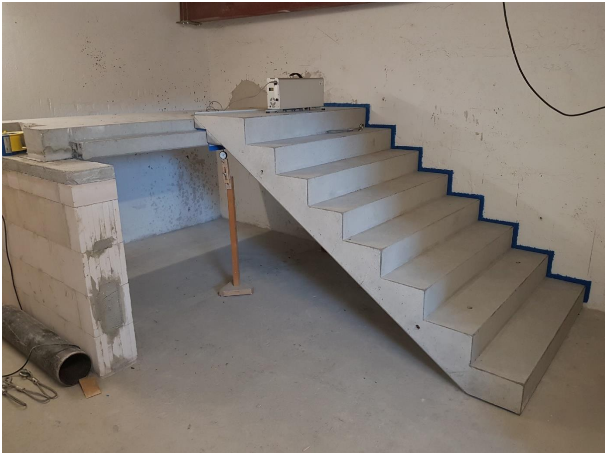
Abbildung 6: Entkoppelter Referenztreppenlauf (Laufbreite 1500 mm) zur Aufbringung der Zusatzlasten
