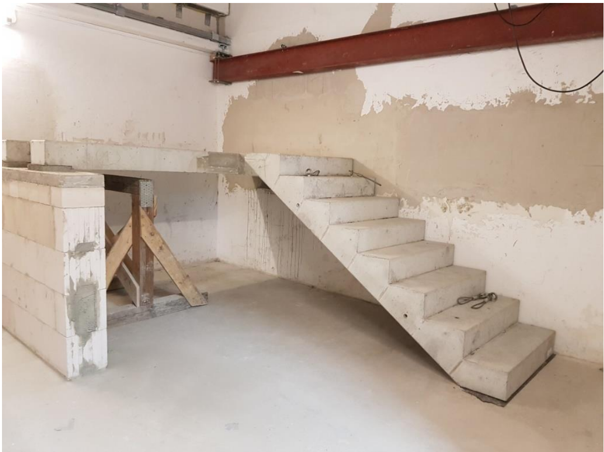
Abbildung 9: Referenztreppenlauf starr an das Referenztreppenpodest angebunden
