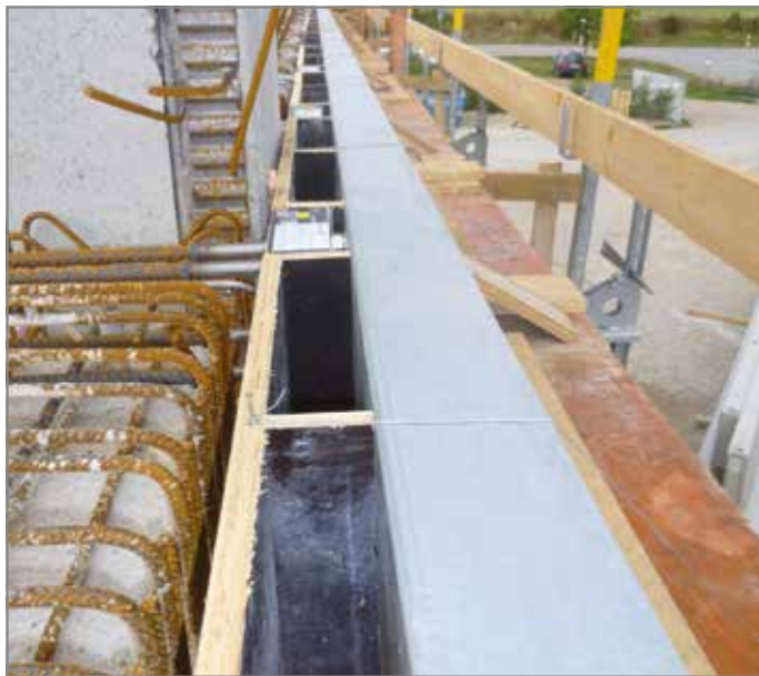
Afb. 27: Aluminium bekistingshulp in ingebouwde toestand
