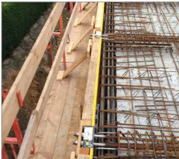
Afb. 24: Gebruik van de optionele inbouw hulp in combinatie met buitenisolatie – de afbeelding toont de bevestiging aan de vloerrandbekisting
