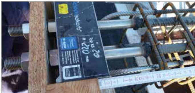
Afb. 23: Gebruik van de optionele inbouw hulp in combinatie met buitenisolatie – de afbeelding toont de bevestiging aan de vloerrandbekisting
