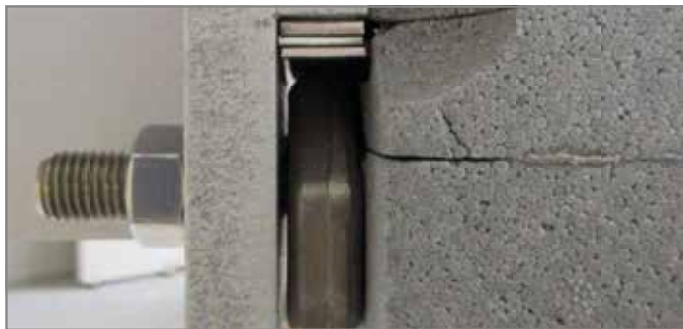
Afb. 33: Opleggen van de staalconstructie met de aan het product aangebrachte onderlegplaatjes ter compensatie van de hoogte
