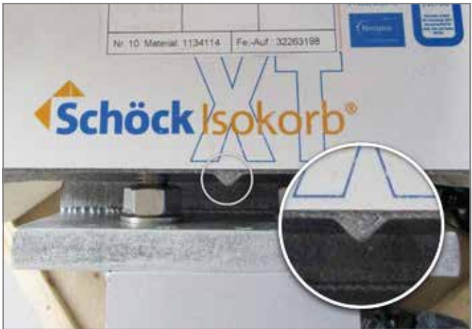
Afb. 21: Middellijn markering van de Schöck Isokorb® Type KS/KSXT
