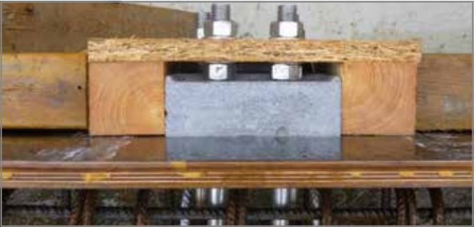
Afb. 25: Gebruik van de optionele inbouwhulp
