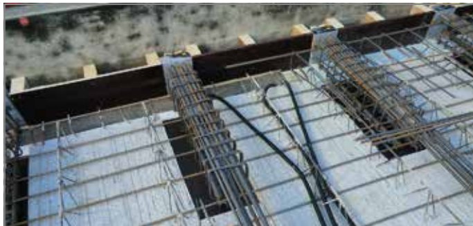
Afb. 19: Uitsparing in de predal bij gebruik van Schöck Isokorb® type KS/KSXT20
