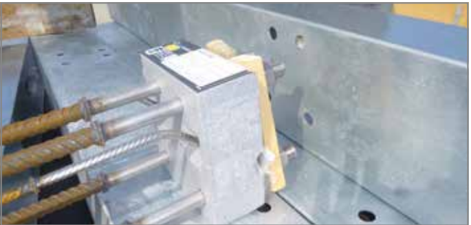
Afb. 26: Gebruik van een aluminium bekistingshulp
