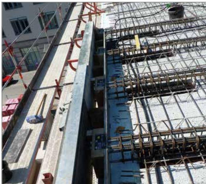
Afb. 29: Bijlegwapening (beugels en overlappingslas) bij gebruik van Schöck Isokorb® KS20
