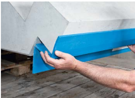
Abb. 3: Typ F ausrichten und aufkleben
