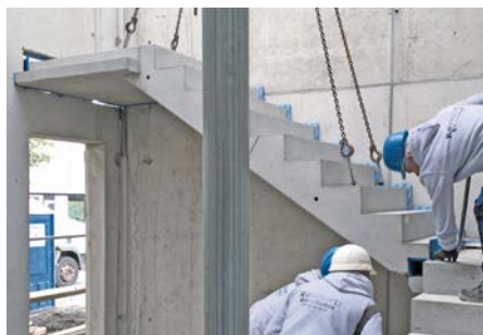
Abb. 10: Treppe einfahren und absetzen
