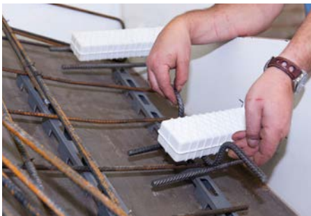
Abb. 3: Hutbügel einsetzen
