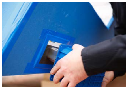
Abb. 10: Typ Q Wandelement aufsetzen
