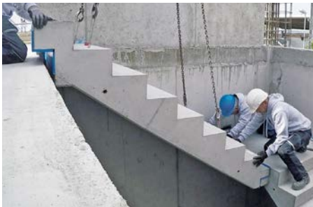
Abb. 12: Treppenlauf wird eingesetzt
