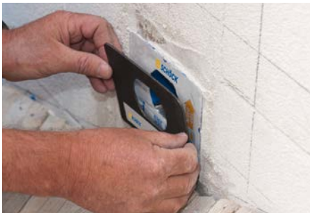
Abb. 6: Typ Q Wandelement einmauern. R 90 Brandschutzabdeckung aufbringen
