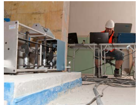
Eingebaute Treppe wird mit Norm-Hammerwerk angeregt.
