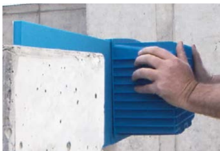
Abb. 9: Typ Z auf Baustelle wieder aufstecken
