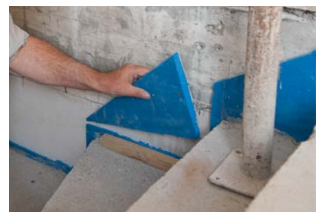
Abb. 11: Typ L Überstand zuschneiden
