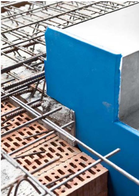
Abb. 12: Die Konsole ist mit Typ F akustisch entkoppelt und die Fuge wird mit Tronsole® Typ L schallbrückenfrei ausgeführt.
