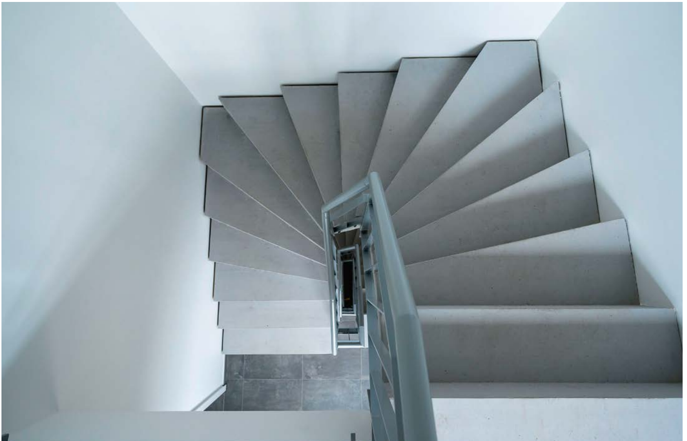
Blick ins Treppenhaus mit Fertigteiltreppe und Holzständerwänden, BVH SaynWood Bendorf-Sayn
