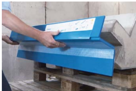
Abb. 4: Typ F ausrichten und aufkleben
