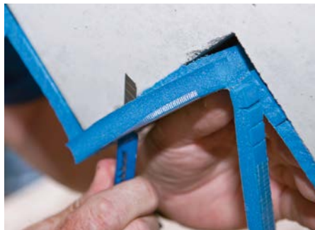
Abb. 4: Typ F Überstand abschneiden
