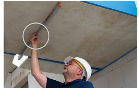
Abb. 14: Podest nach Ablegen der Treppen- läufe auf waagerechten Sitz überprüfen
