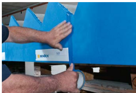
Abb. 10: Typ L Fugen mit Klebeband abdecken
