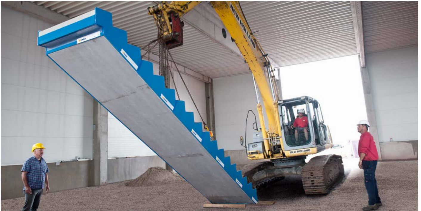
Abb. 11: Der mit Tronsole® umlaufend beklebte Fertigteiltreppenlauf kann direkt auf der Baustelle eingesetzt werden.
