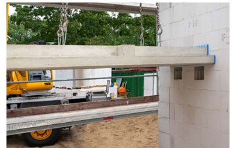
Abb. 5: Podest zwischen den Treppenhauswänden einheben
