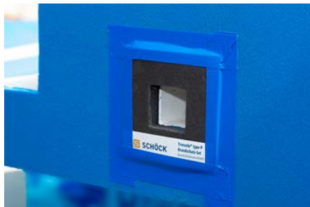
Abb. 4: Brandschutzmanschette einsetzen und abkleben
