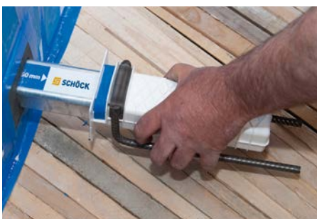
Abb. 9: Typ Q Laufhülse aufstecken
