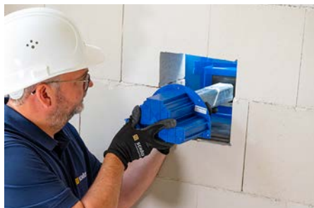
Abb. 10: Tragelement und Wandelement in Podesthülse einfahren und abkleben
