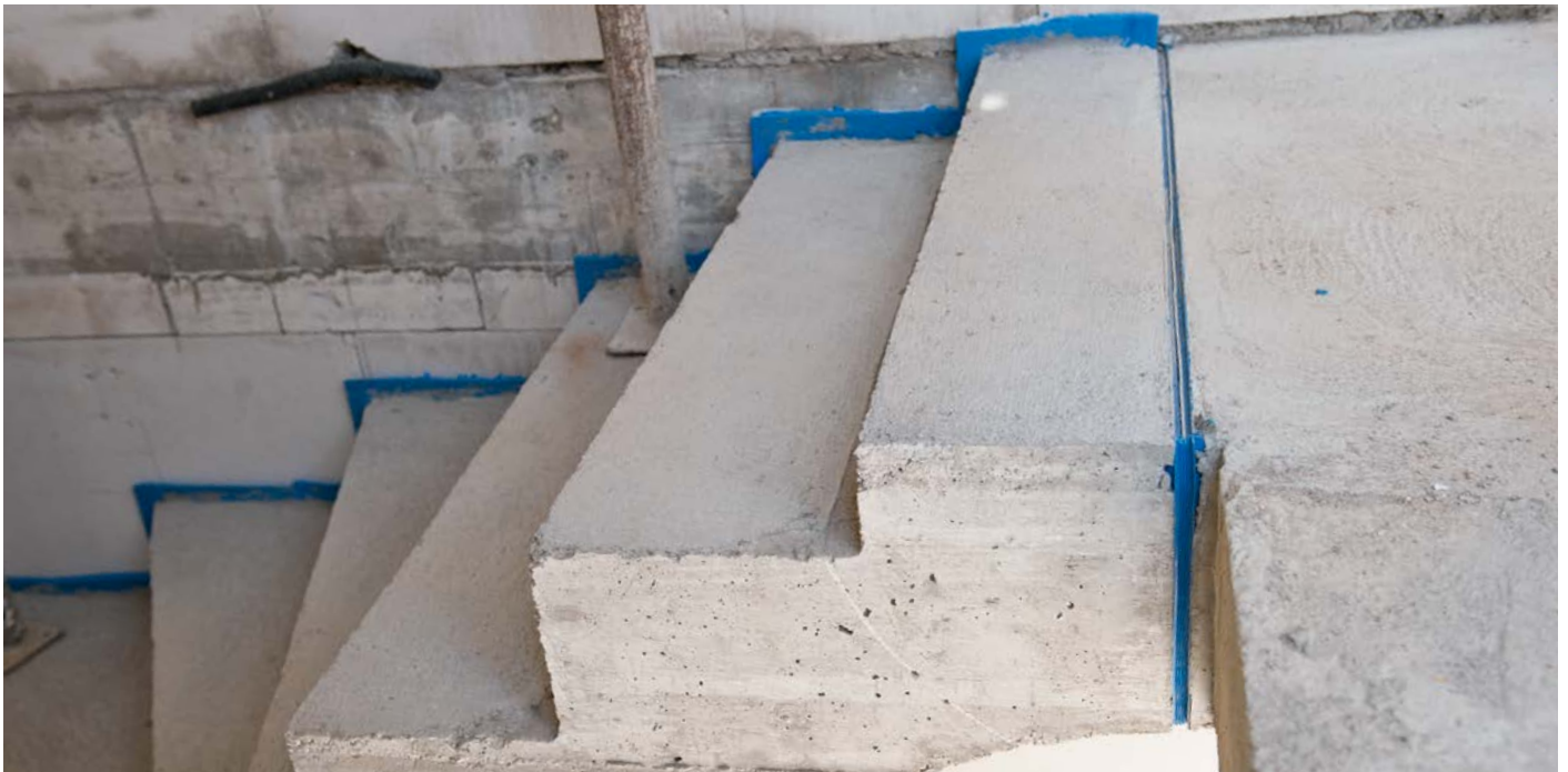
Abb. 12: Gerade Fugenausbildung am Treppenaustritt
