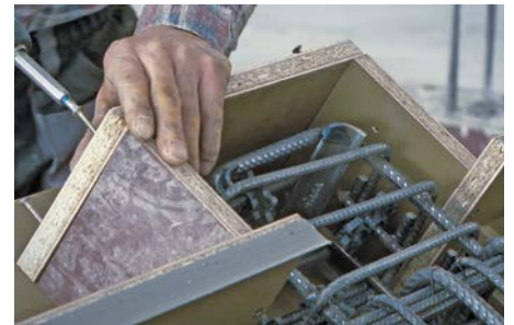
Abb. 2: Konsole fertig schalen, anschließend betonieren
