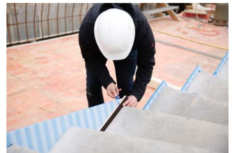
Abb. 8: Typ L mit Überstand zuschneiden
