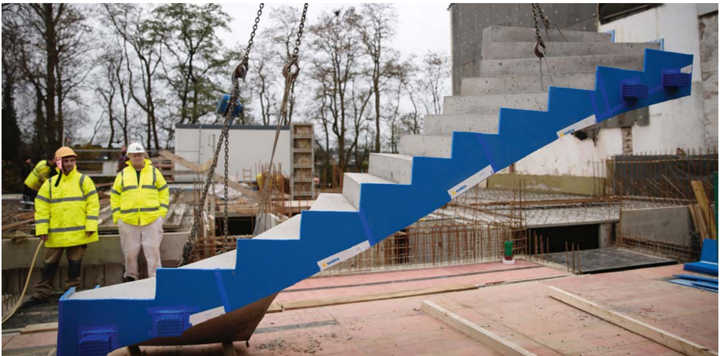
Abb. 11: Treppe anheben und einfahren
