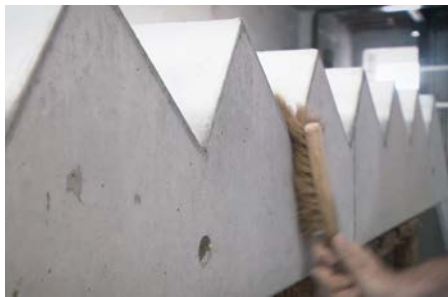
Abb. 3: Staub und Schmutz entfernen
