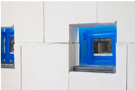
Abb. 6: Podest auf Höhe der Wandaussparungen positionieren
