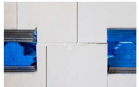
Abb. 11: Einstellung von Höhe und ggf. abhebender Kräfte mittels Ausgleichsplatten
