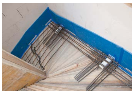
Abb. 10: Bewehrung verlegen und betonieren
