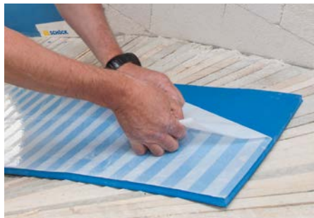
Abb. 4: Typ L Folie zur Hälfte entfernen
