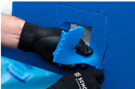
Abb. 3: Geometrie der Brandschutzmanschette ausschneiden
