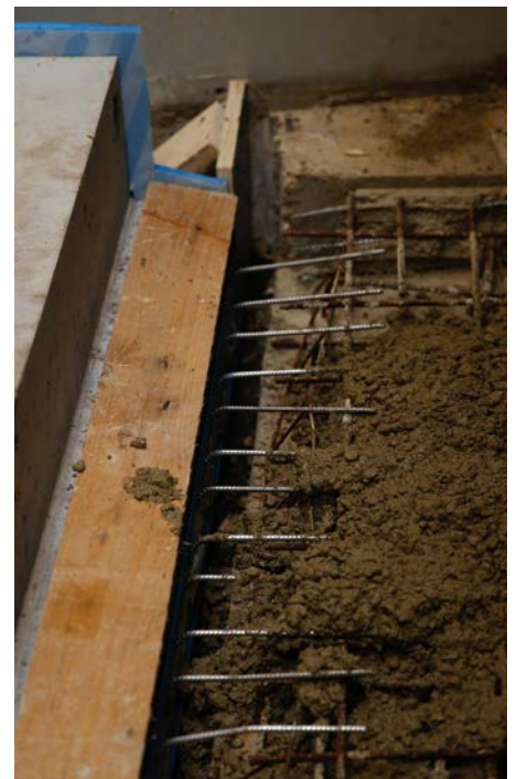
Abb. 13: Anschlussbereich Typ T betonieren
