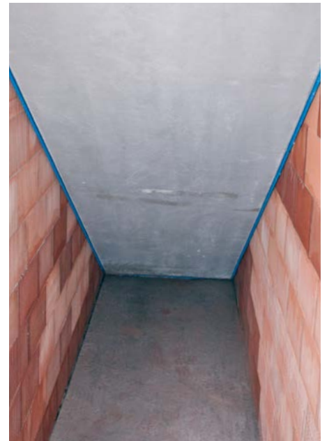
Abb. 14: Die blaue Linie zeigt den schallbrückenfreien Einbau als Qualitätsmerkmal für einen sicheren Trittschallschutz.
