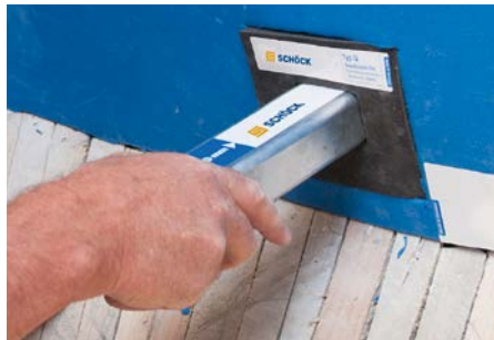
Abb. 7: R 90 Brandschutzmanschette einbauen. Typ Q Tragelement einschieben.
