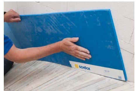
Abb. 5: Typ L untere Hälfte aufkleben
