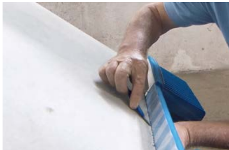
Abb. 6: Typ L Klebefolie einritzen
