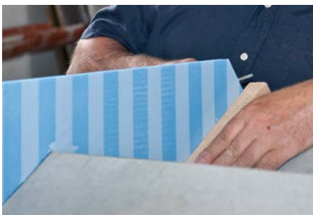
Abb. 9: Typ L mit Überstand zuschneiden
