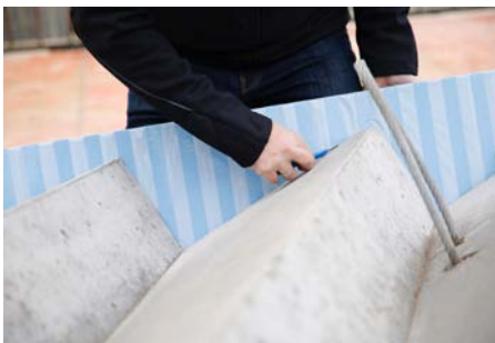
Abb. 6: Typ L Klebefolie einritzen
