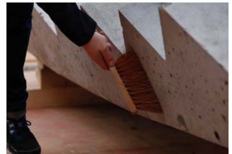
Abb. 5: Staub und Schmutz entfernen
