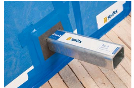
Abb. 8: Fugen mit Klebeband abdecken
