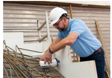
Abb. 2: Typ Q Laufhülse einbauen
