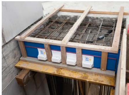
Abb. 1: Typ T einsetzen und stützen
