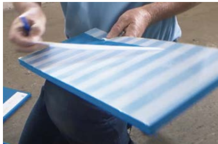
Abb. 7: Typ L Klebefolie entfernen und aufkleben
