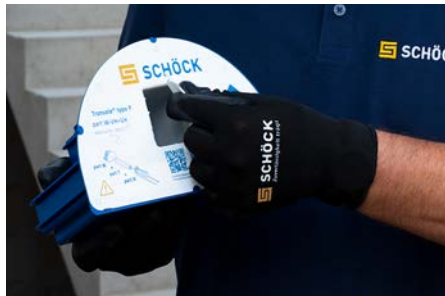
Abb. 7: Klebefolie am Wandelement an der perforierten Stelle entfernen
