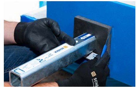
Abb. 2: Brandschutzmanschette und Tragelement positionieren
