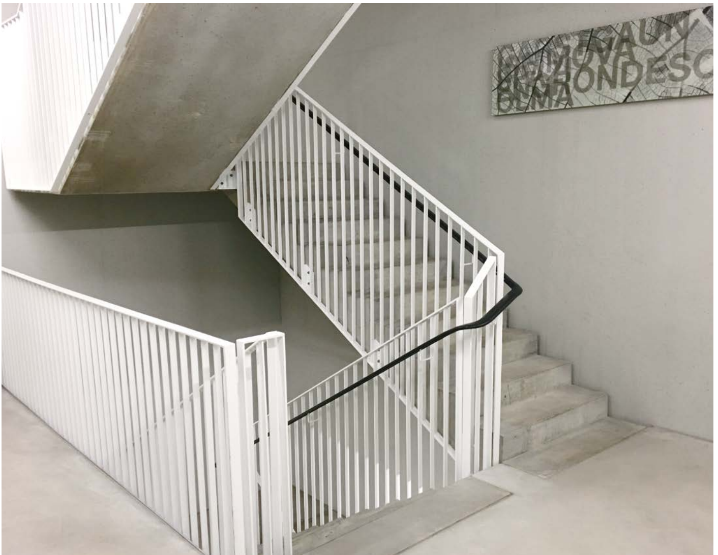
Sichtbeton-Treppenhaus im Transitlager, Basel
