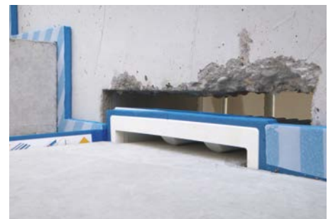
Abb. 11: Wandöffnungen mit Mörtel verfüllen
