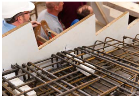
Abb. 4: Bewehrung verlegen und betonieren
