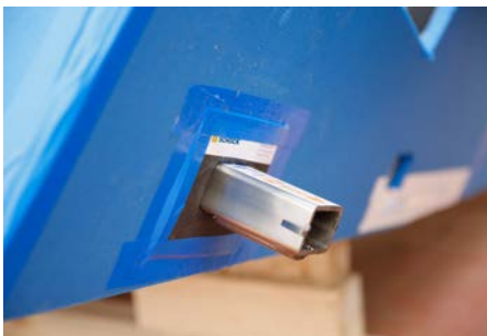
Abb. 9: Typ Q Tragelement mit Brandschutzmanschette einbauen
