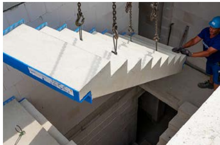
Abb. 13: Treppenlauf einheben
