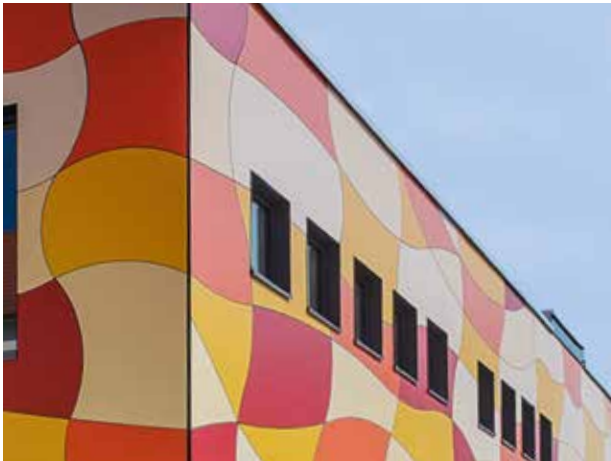
Beispiel VHF: Gymnasium, Hoyerswerda © bauhoys Planungsbüro
