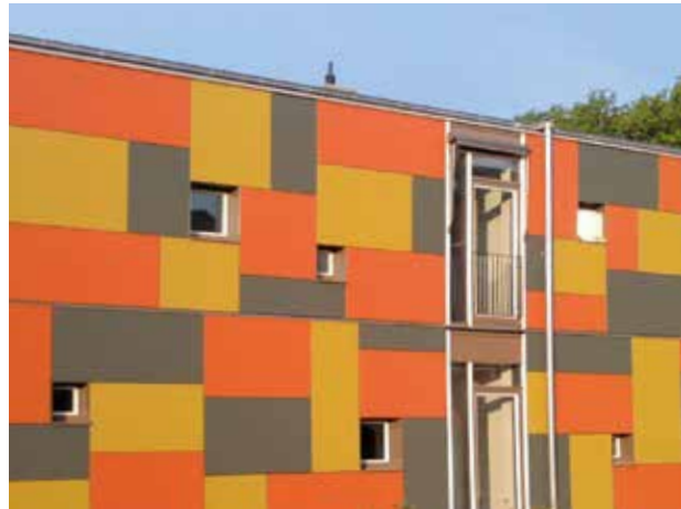
Beispiel VHF: KITA St. Konrad, Burghausen © AS Fassaden GmbH
