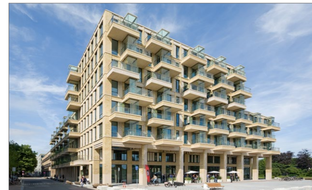
Jälkiasennettuja parvekkeita Square Amsterdam -projektissa Hollannin Amsterdamissa
