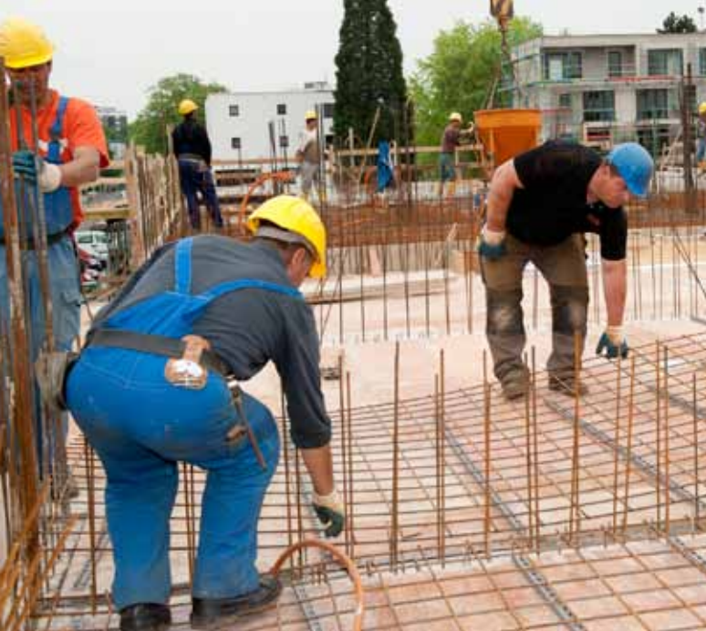
Letzte Kontrolle der Stahlbewehrung: Nachdem die Arbeiter mit den Vorbereitungen fertig sind, können der Polier und der Einbaumeister den Isokorb® platzieren.
