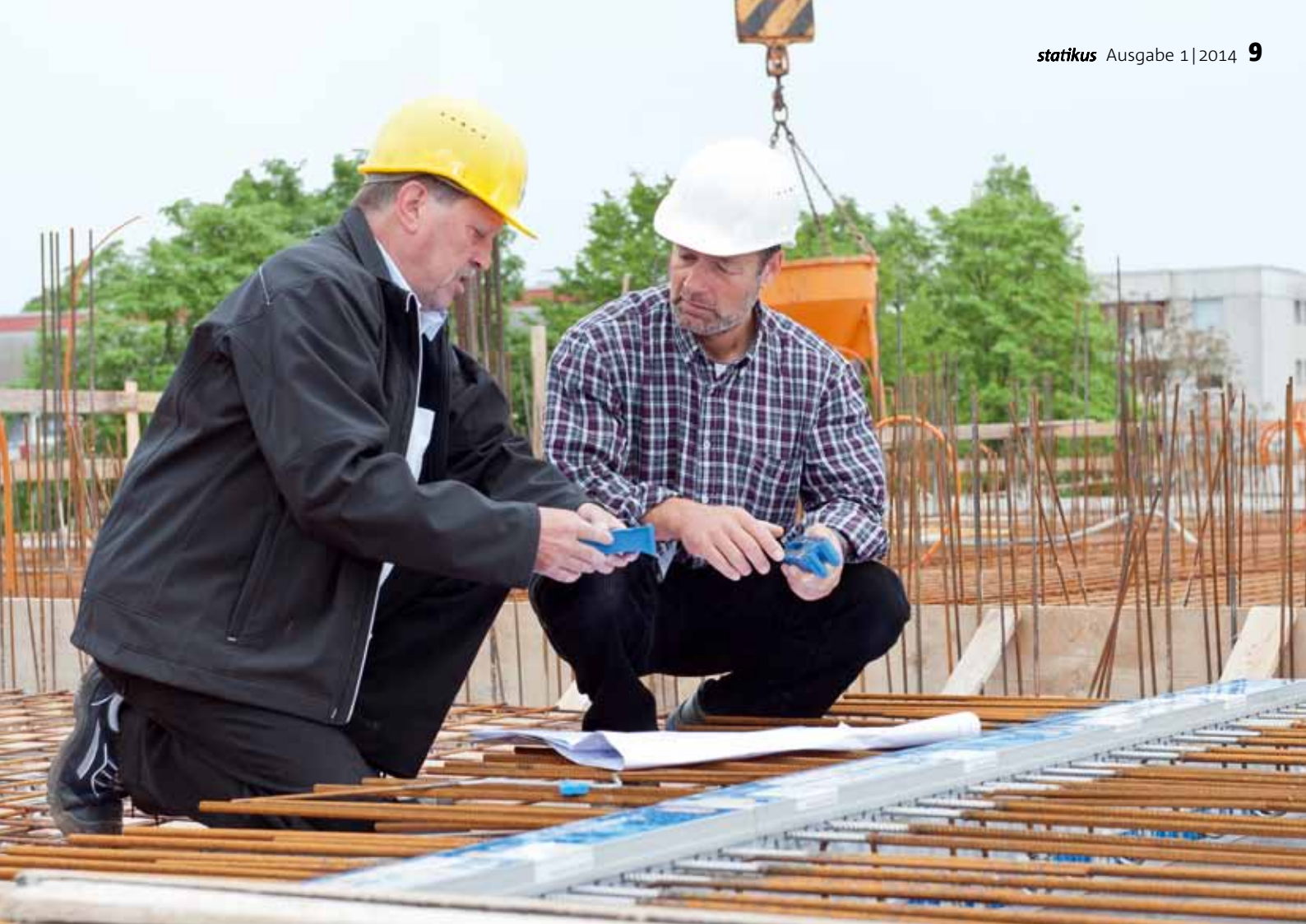
Lagebesprechung auf der Baustelle: Einbaumeister Jens Neumann (links) und Polier Roland Pöpper studieren den Bauplan und diskutieren, wie sie den Schöck Isokorb® einbauen wollen. Die richtige Technik ist wichtig, damit die Wärmedämmung später richtig funktioniert.
