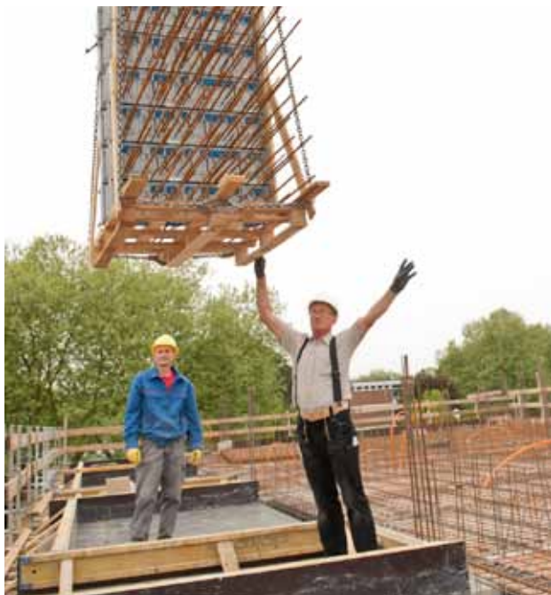
Per Kran bugsieren die Arbeiter die Bauteile an die Stelle, an der sie eingebaut werden sollen. Nun ist alles für den Einsatz des Einbaumeisters vorbereitet.
