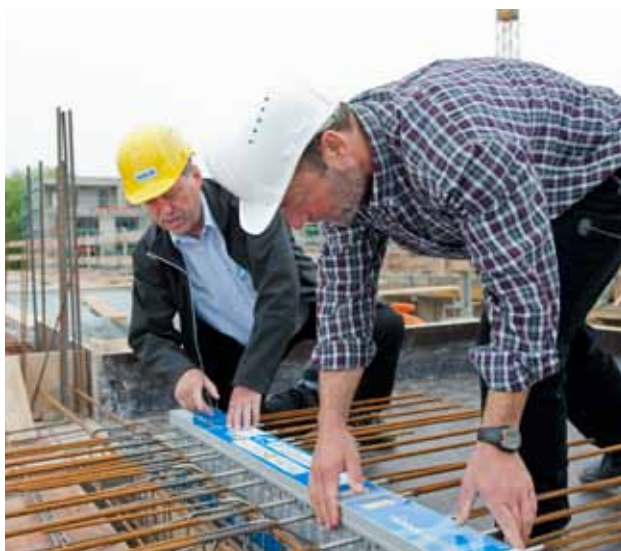
Der Isokorb® ist zentimetergenau eingesetzt. Neumann und Pöpper prüfen noch einmal, ob alles sitzt, bevor die Arbeiter den Beton gießen.
