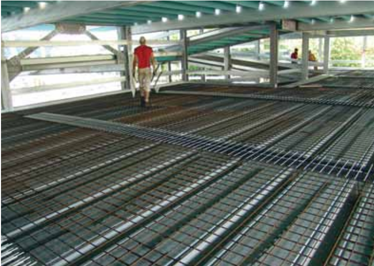
Parkeergarage in het gezondheidscentrum aan de Nahe in Bad Kreuznach
