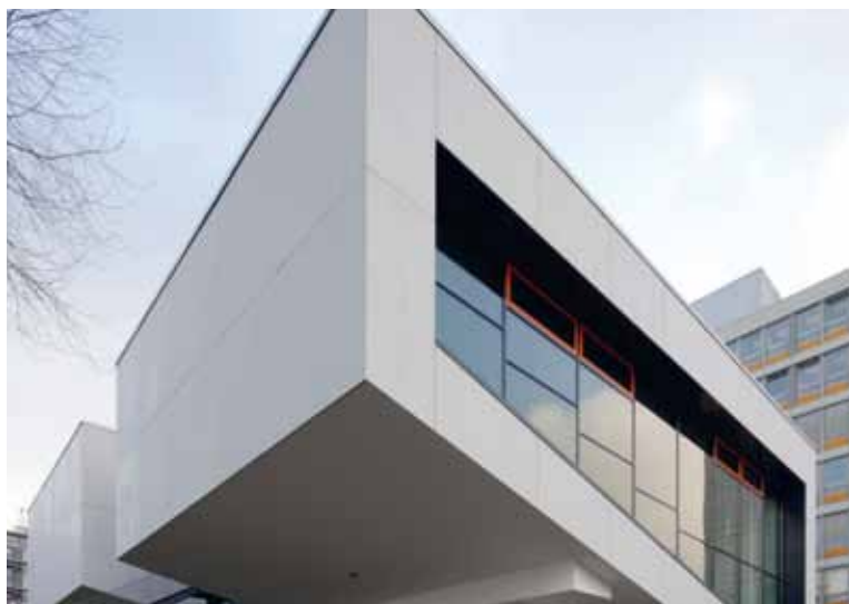
Gevelplaten van het auditorium van de RWTH Aken
