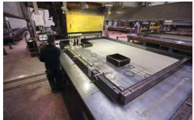
Stap 2: De eerste betonschil van de sandwichwand wordt gestort.
