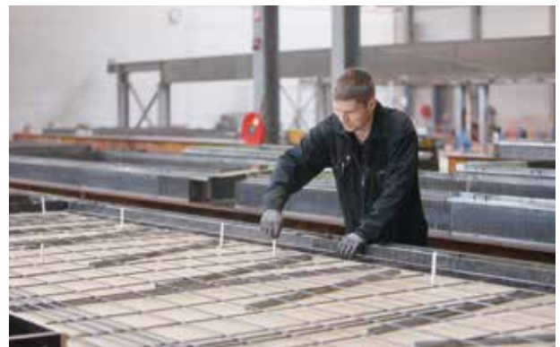
Stap 4: Inbrengen van de Isolink staven in de voorgeboorde gaten en in de verse betonschil.
