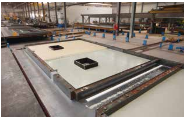
Stap 3: De isolatieplaten, met voorgeboorde gaten, worden op de vers gestorte betonschil gelegd.
