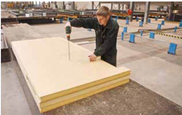
Stap 1: Voorboren van gaten in de isolatie om de Isolink® staven in te brengen.
