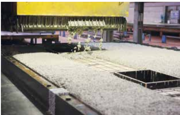
Stap 5: De tweede betonschil van de sandwichwand storten en laten uitharden.
