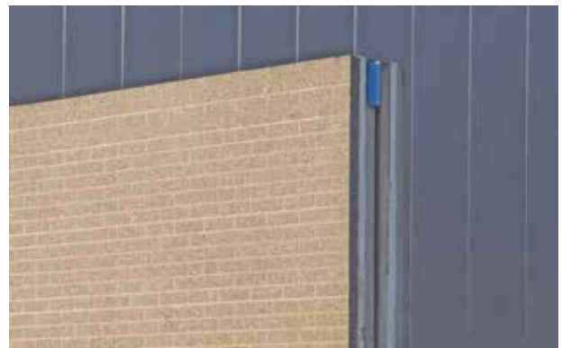
Stap 6: De in de kern geïsoleerde sandwichwand is klaar voor transport naar de bouwplaats.
