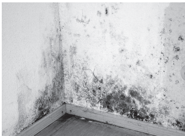
Príklady napadení plísněnými škůdci v oblasti tepelných mostů.
