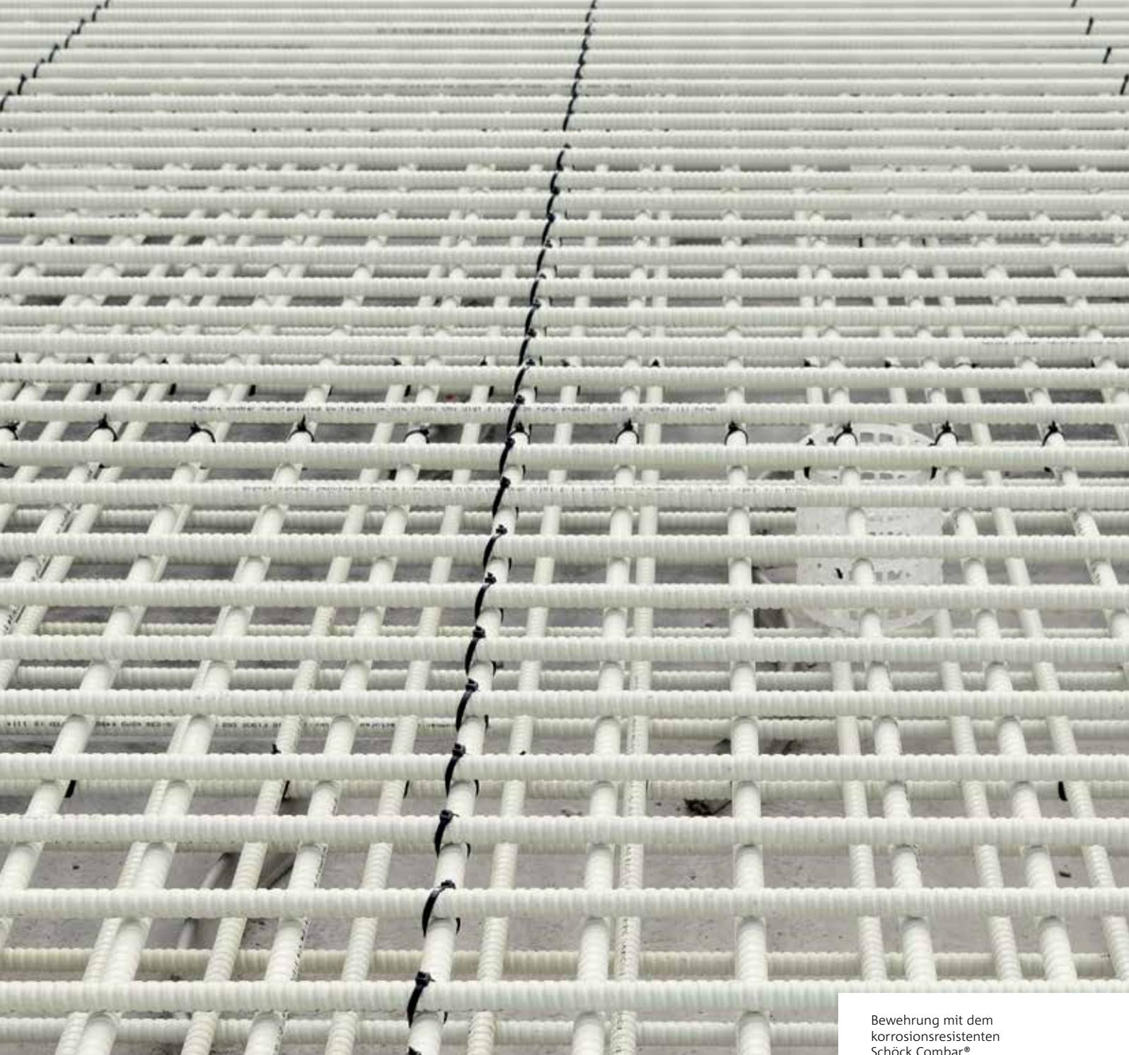
Bewehrung mit dem korrosionsresistenten Schöck Combar®
