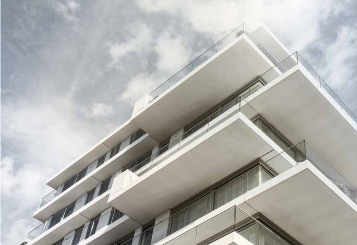
Coolhouse, Países Bajos. Foto: Luuk Kramer fotografie
