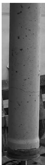
Première fissure (150 N/mm 2 )
